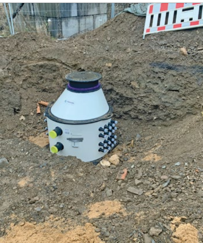
Die Schächte für die Erdsondenfelder haben beidseits je 16 Anschlüsse für die einzelnen Bohrungen sowie je einen Anschluss für den Vor- und den Rücklauf der Netzleitungen.
