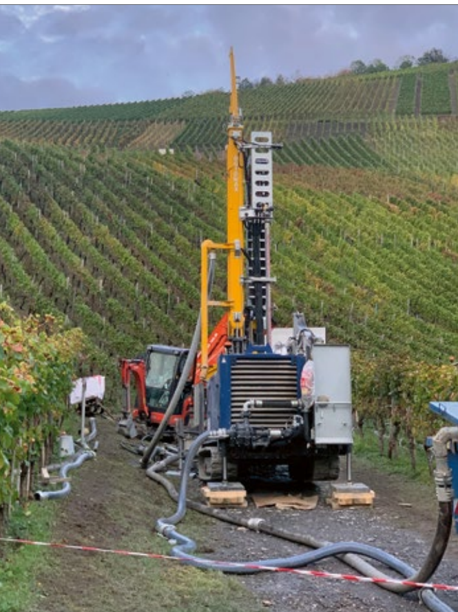
Die 150 Meter tiefen Erdsondenbohrungen fanden an bislang drei Stellen am Rand des Ortes statt.
